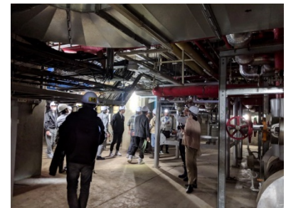
図10 筑波大学学内共同溝
